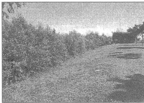
写真-11 マングローブ成長後の西護岸(2003.12)
