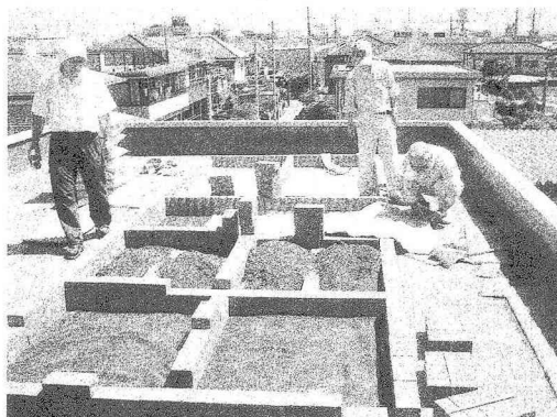
写真-2 施工の様子(奥の区画からドレイン材、衝撃保護マット、排水ドレインシート、耐根シートが見える)
