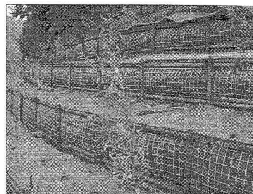
写真-3 草木ダムの事例 （階段工を用いた挿し木工法）
