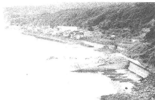
写真-1 木野部海岸北西部にある緩傾斜護岸
