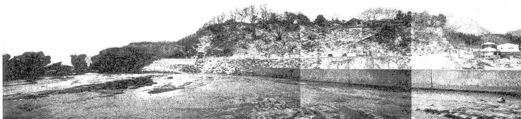
写真-5 赤川地区の完成後の護岸状況
