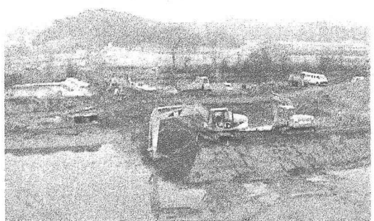
写真-1 八坂川の新河道の工事。旧河道の河畔林が残存。
