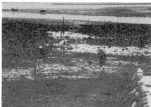
写真-3 養浜砂入れ替え時の測量状況
