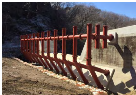
写真-2 張り出しタイプ流木捕捉工
