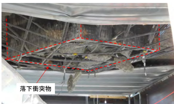
図-9 落下高さ 15m 衝突後の裏面状況
