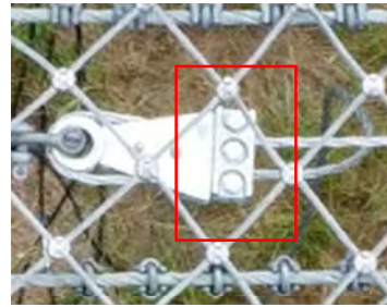
図-2 摩擦摺動型緩衝装置
