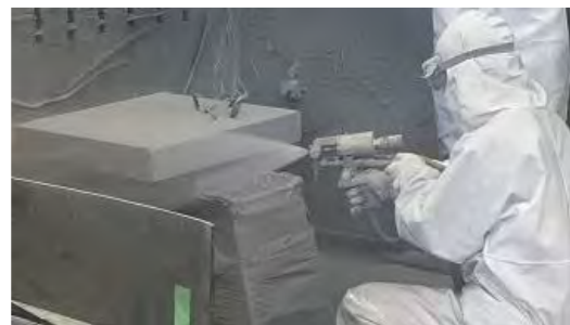
写真-1 吹付けの様子
