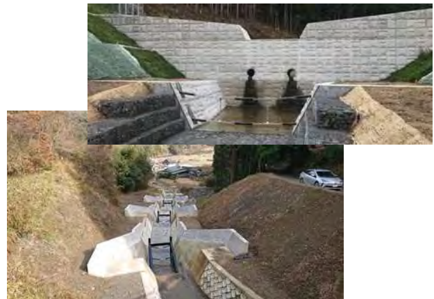
写真-1 流木捕捉工の事例
