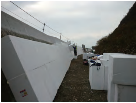
(a) EPS ブロック設置状況 7)
