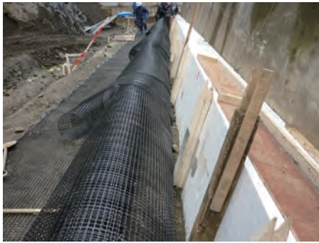
(b) ジオグリッド設置状況 8)
