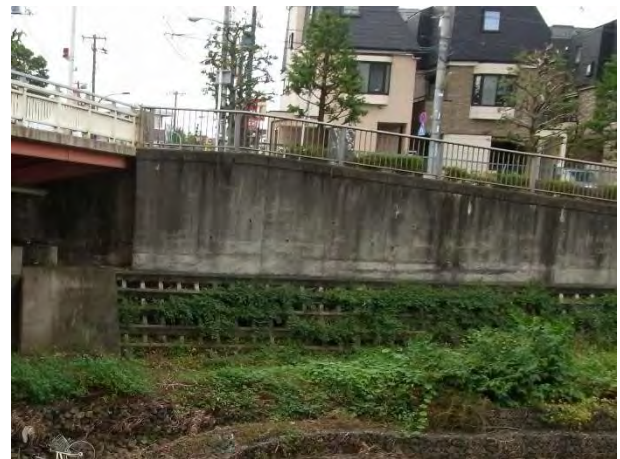
写真1. ブロック積護岸上の取付擁壁（例）
