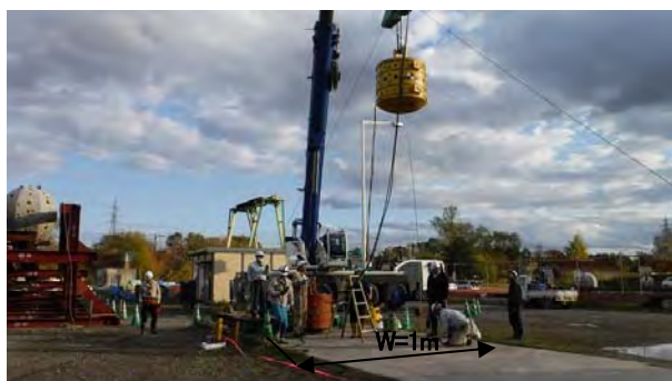
写真一 実験状況 (コンクリート地盤, 重錘 3.0t)
