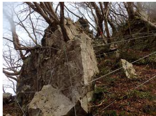
図-10 ロープ掛け工
