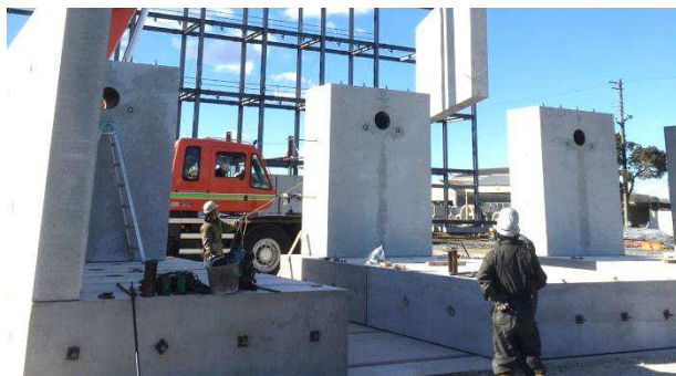
図-4 基礎反力壁の組立状況
