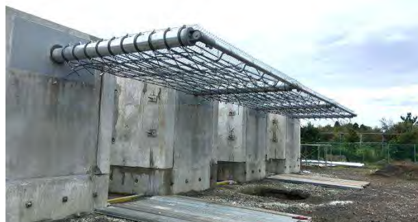
図-5 供試体設置状況
