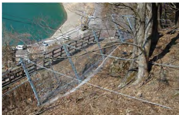
写真-1 ワイヤロープ支持式落石防護柵
