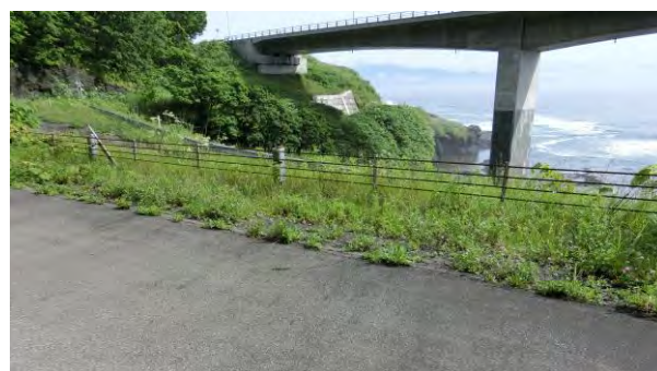
写真-2 試験材料採取箇所(ケーブル型防護柵)
