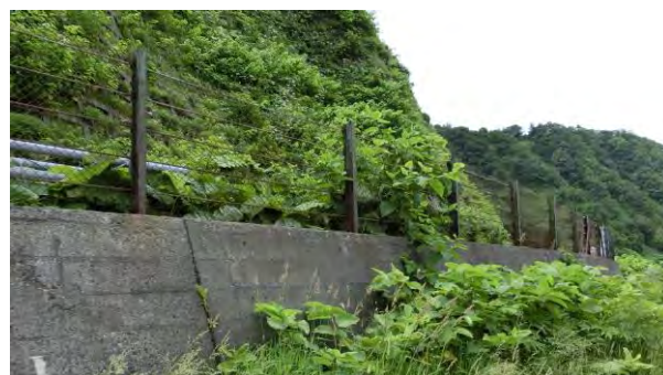
写真-1 試験材料採取箇所(落石防護柵)
