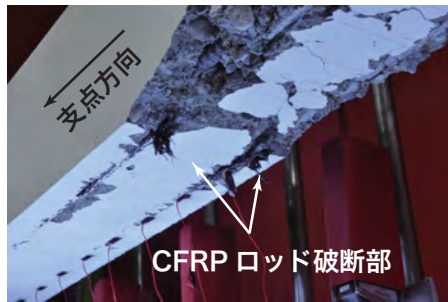
(a) 左側スパン底面の状況
