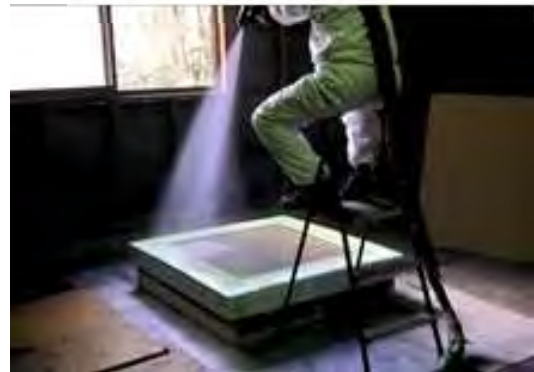
写真-2 ポリウレアの吹付状況
