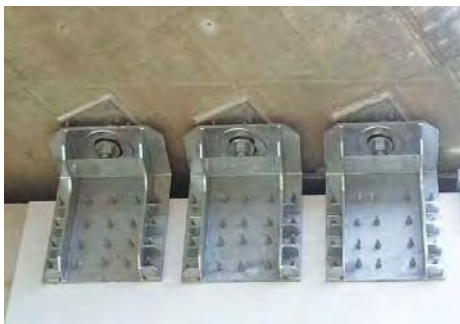
写真-1 緩衝材付きアンカーバーの桁下への設置事例
