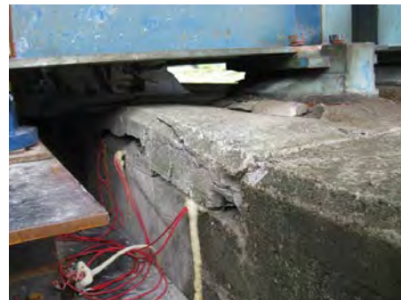
(d) 橋梁の支承部取替工事
