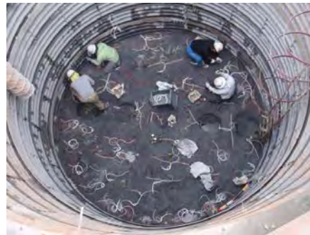
(b) 深礎掘削
