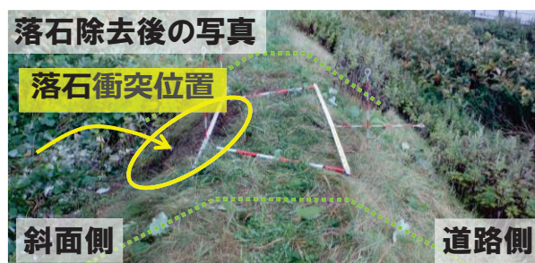
図-1 落石防護土堤の写真
