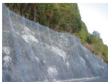
写真-1 ポケット式落石防護網
