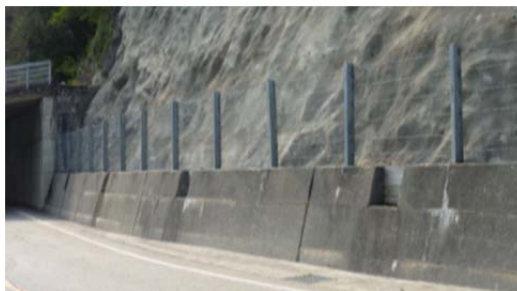
写真-1 ワイヤロープ金網式落石防護柵の例
