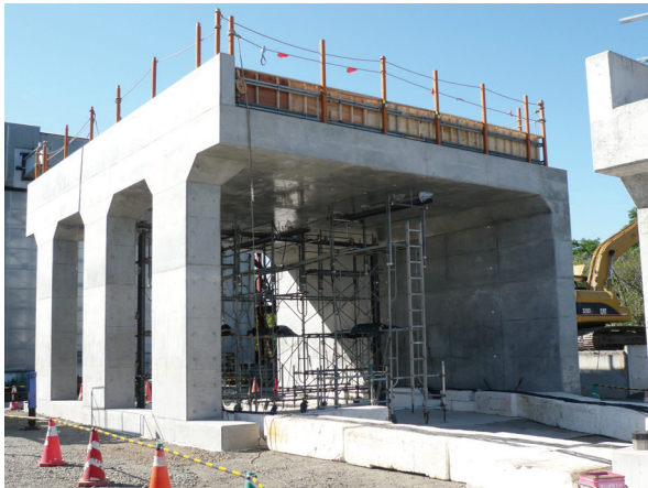
写真-1 実規模 RC 製ロックシェッド
