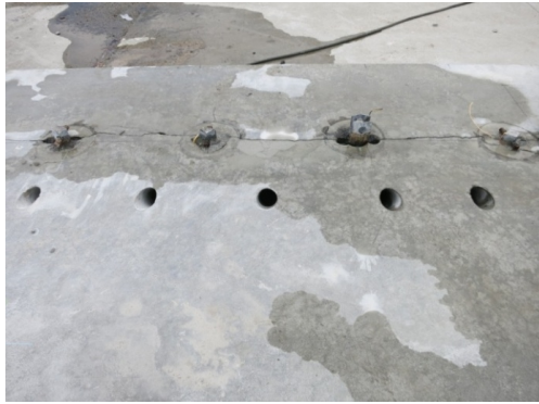
写真-10 はつり破碎のための装薬孔の配置
