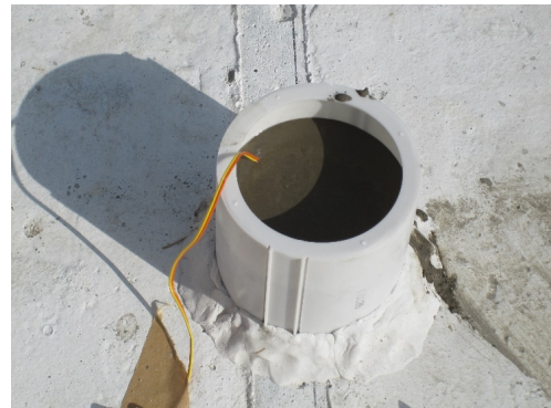
写真-3 試験体上部のグラウト材の充填状況
