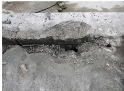
写真-13 はつり破碎の状況
