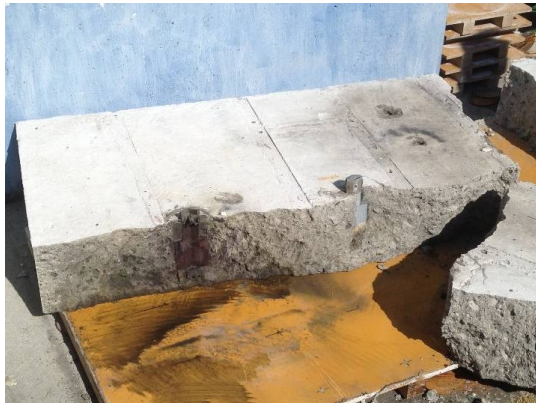
写真-5 スラブ長辺方向での破断面形成状態
