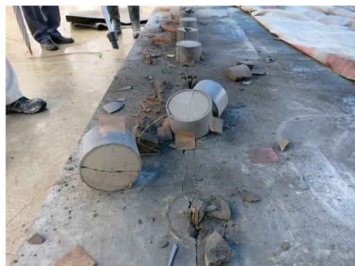
写真-9 点火後の破碎状況
