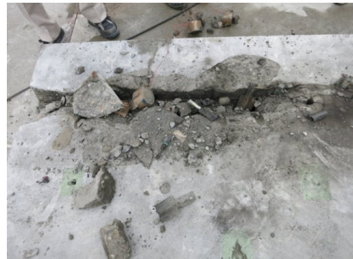
写真-12 点火後の破碎状況
