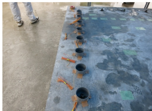
写真-8 配置された8孔の装薬ホルダー
