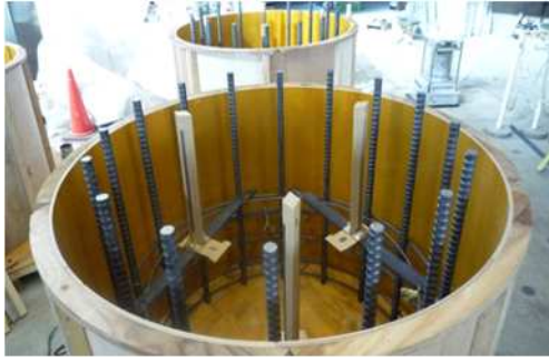
写真 - 4 試験体 3 型枠・鉄筋装薬ホルダ設置状況 (両方向×3)
