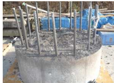
写真 - 19 破砕状況（破砕面）
