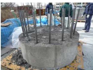
写真 - 24 破砕状況 (破砕面)
