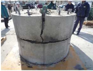
写真 - 27 破砕状況 (直後)
