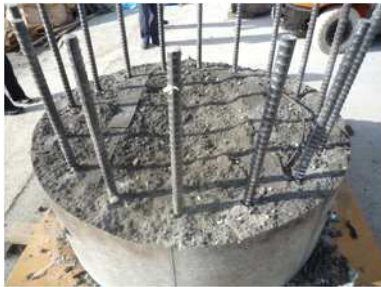
写真 - 28 破砕状況 (破砕面)
