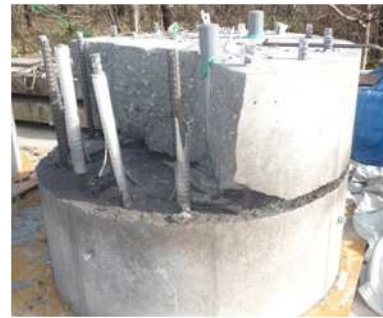
写真 - 18 破砕状況（直後）
