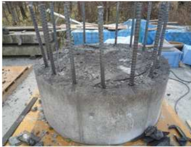
写真 - 15 破砕状況（破砕面）
