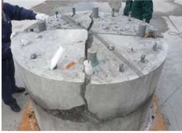
写真 - 14 破砕状況（直後）
