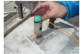
写真 - 9 粘土材充填
