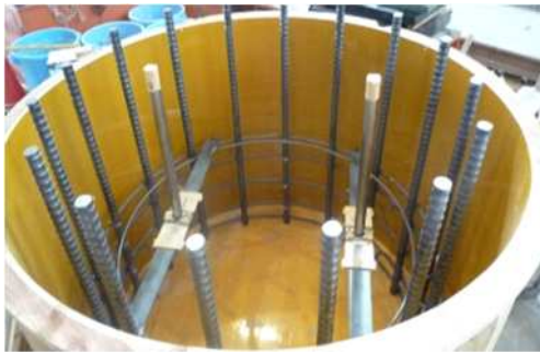
写真 - 5 試験体 4 型枠・鉄筋装薬ホルダ設置状況 (水平×2)
