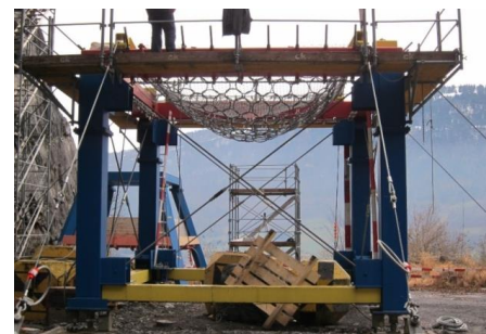
写真-5 2層ネット設置状況 (No.8, No.9)
