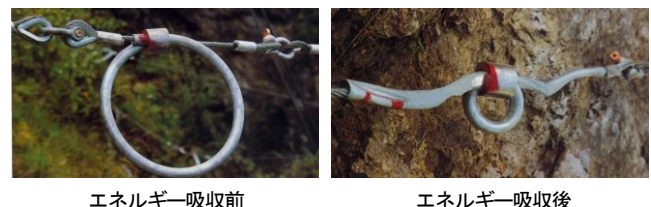
図-3 エネルギー吸収装置
