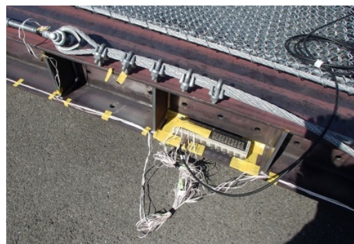
図6 ターンバックルでの張力測定
