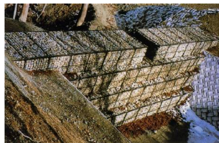
写真-1 鋼製枠堰堤
