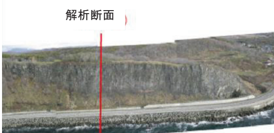
写真-4 落石シミュレーション対象斜面
