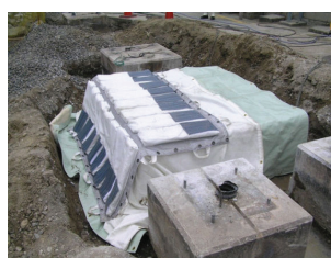
飛散防止養生
