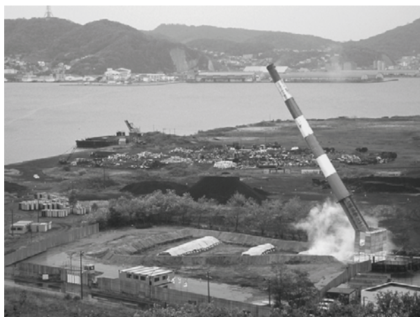
写真-1 RC造煙突に対する転倒式発破解体の実施
