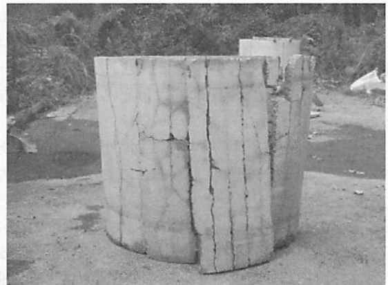
(b) 試験体の損傷状況
