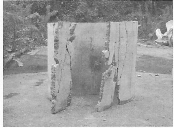
(b) 試験体の損傷状況
