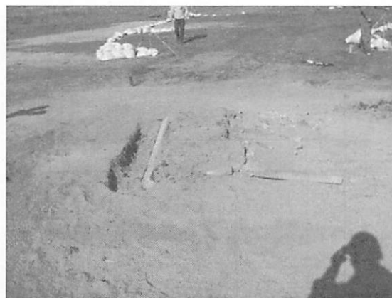
図5 倒壊した防爆壁の状況
