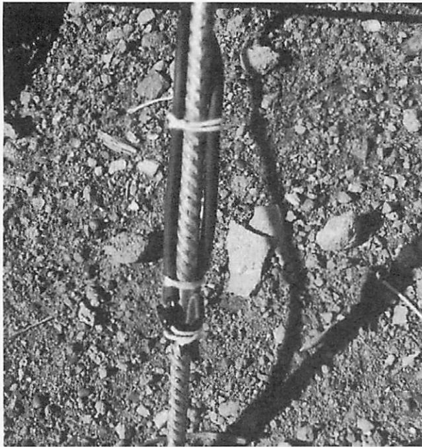
図2 鉄筋に設置した状態のひずみゲージ (打設前)
