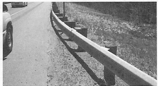
写真-1 支柱に木材を使った防護柵の例 2)
