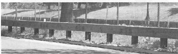
写真-2 米国の代表的木製防護柵 3)
