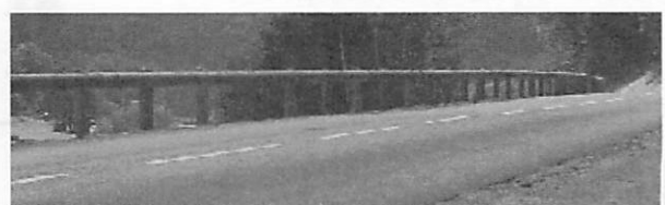
写真-3 フランスの代表的木製防護柵 4)
