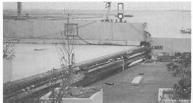
写真-2 段差による通行支障
