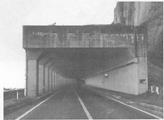
写真-1 落石防護覆道の一例
