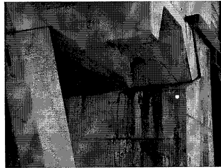
写真-2 No.1 支承部
