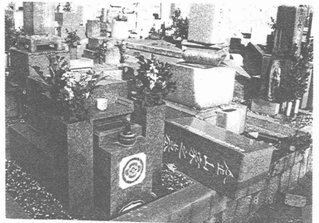
写真-10 回転した亀澤家墓石と破断した台座
