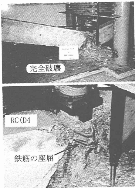
写真-3 破壊状況 (RC はり)
