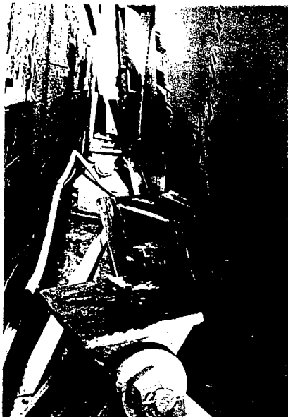
写真1 ピボット支承（固定支承）上沓の割裂破壊状況
