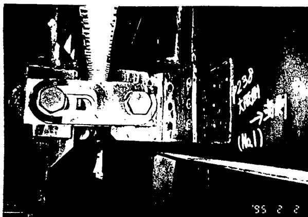
写真6 タイバー形式桁間連結装置の取付けボルトの引張り破断状況
