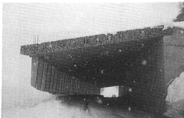
写真-1 スノーシェッド
