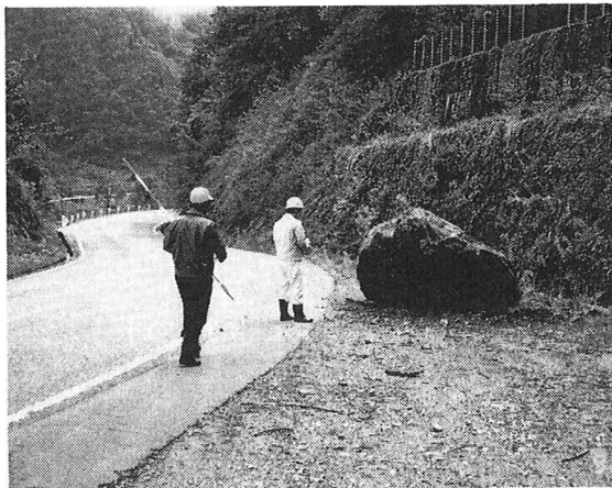
写真-1 第1線に落下した巨岩
