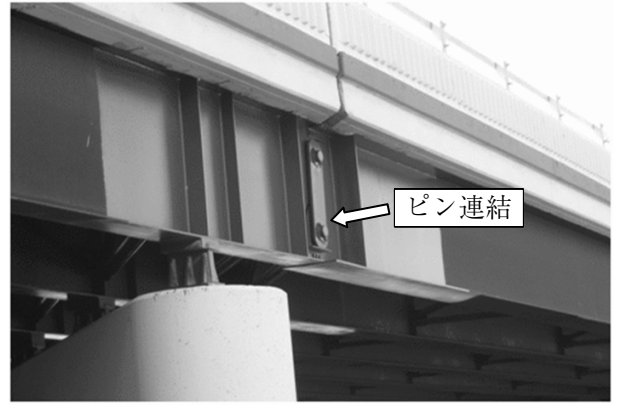
図-3 実橋梁におけるピン連結の例
