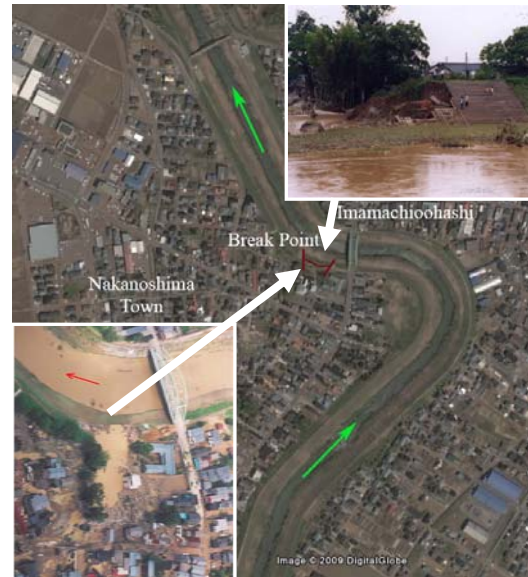
図-1 刈谷田川堤防決壊地点
