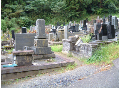
写真-1 コンクリートの基礎上の無被害の墓石（左）と砂利の上で転倒した墓石（右）
