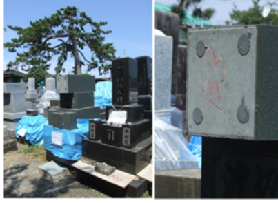
写真-2 接着補強された棹石の転倒(左)と棹石下面の接着剤が剥がれた様子(右)
