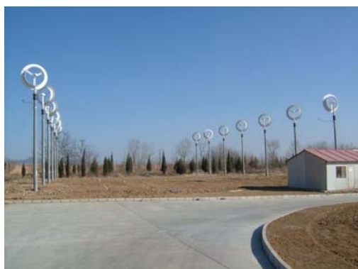
図-18 中国の清華大学 (INET) に建設した1kW風レンズ風車のウィンドファーム
