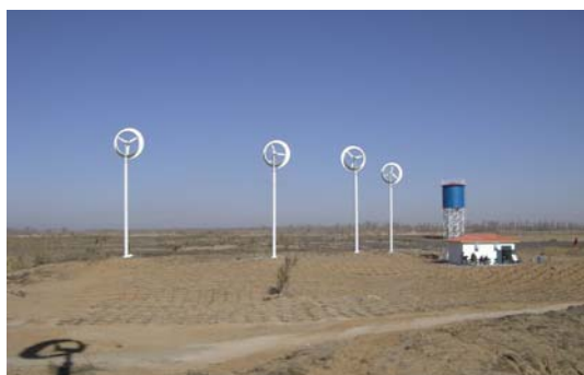
図-19 中国甘肅省の砂漠に灌漑目的で建設した5kW風レンズ風車ウィンドファーム
