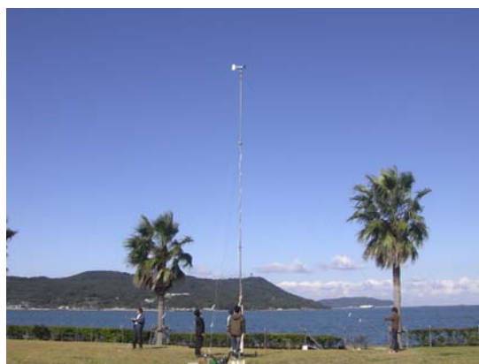
図-22 風況観測のための風向・風速計ポール設置
