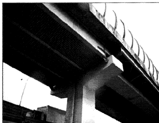
写真-1 騒音が確認された実橋 橋梁構造形式の変化点（ジョイント部分）
